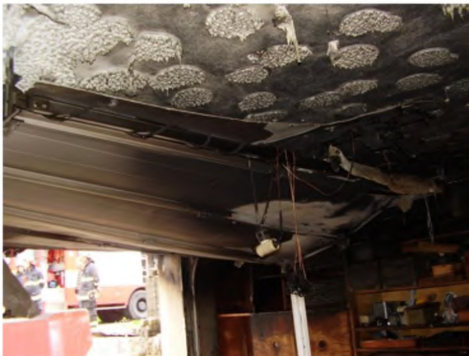
Obr. 6 Obhorená izolácia a garážová brána
