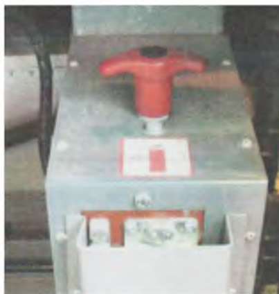
Obr. 12 Hlavný (mechanický) odpájač
