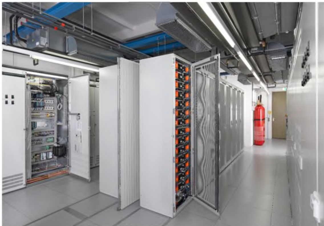
Obr. 1 Energetické systémy s Li-ion batériami v kontajneri a v stavbe
